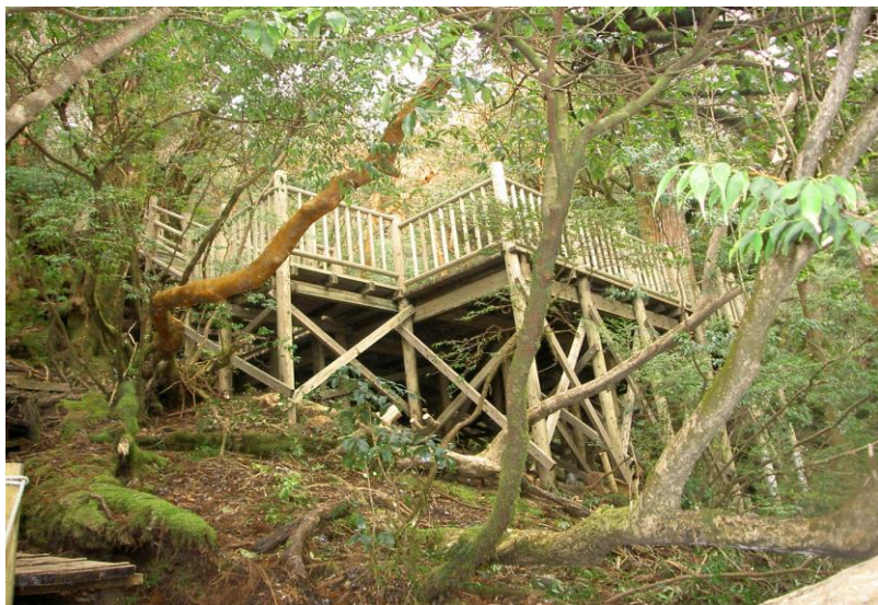
下山ルートより望む 今回整備した展望デッキ (南東方向より撮影)
