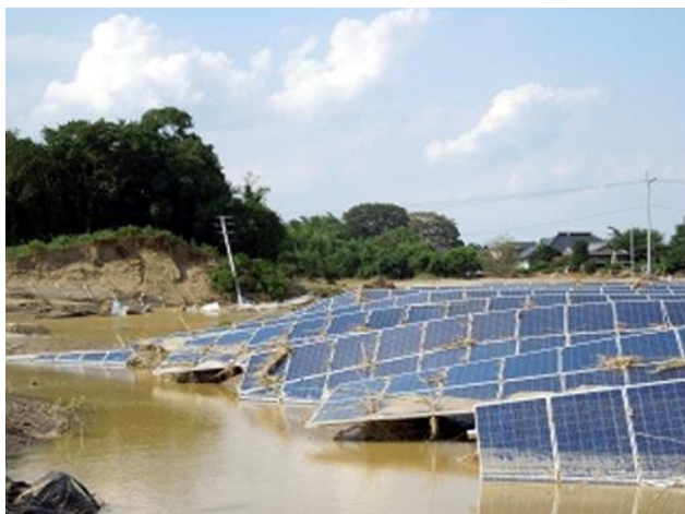
写真 2-1 太陽光発電設備の被災状況
