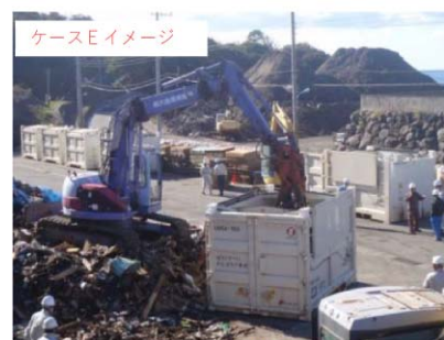
12ft コンテナへの積込状況 (混合廃棄物) [大島町災害相廃棄物処理記録(2015 年 3 月より)]
