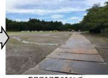
敷鉄板を設置することで、車両の通行を円滑に。
