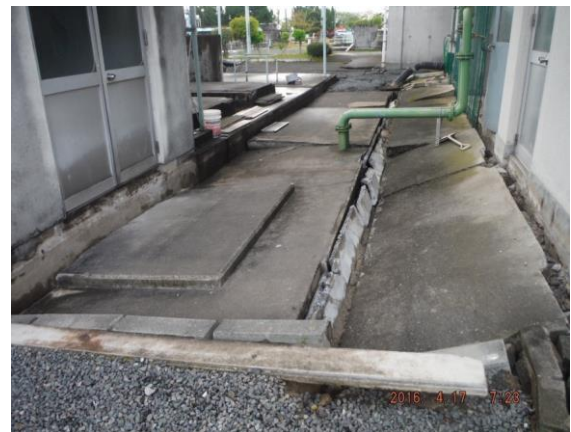
前処理棟・貯留槽間（陥没）
