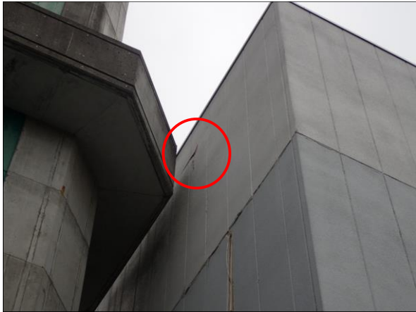
建屋外壁（煙突と接触し破損）
