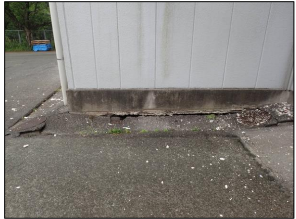
灰バンカ室付近地割れ、沈下
