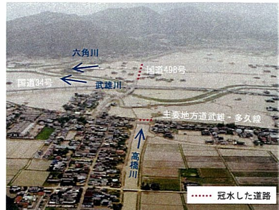
平成2年7月出水の浸水状況
