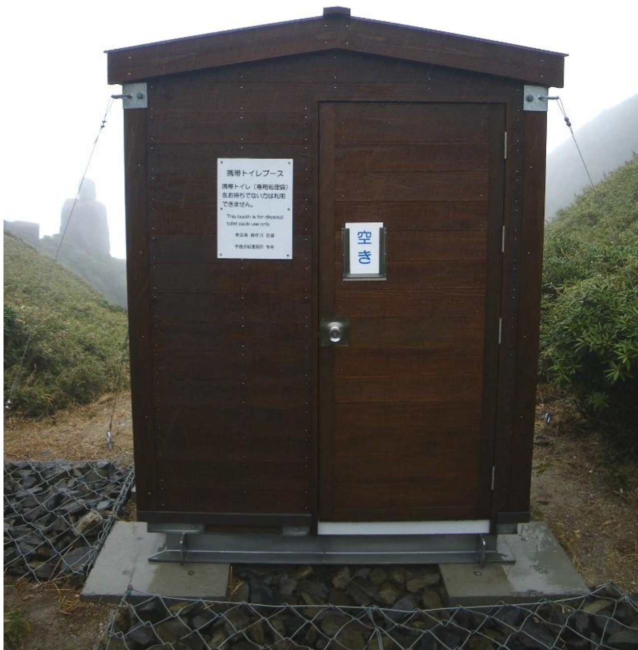
翁岳の携帯トイレブース(1室)
