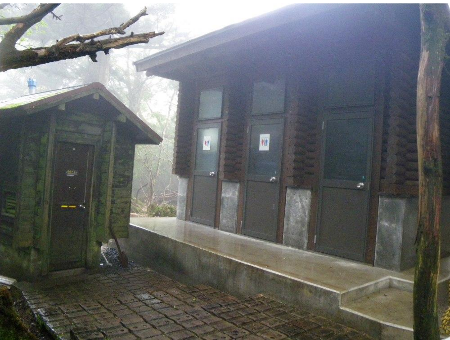
既設汲取り式トイレ(左)と新設トイレ(右)
