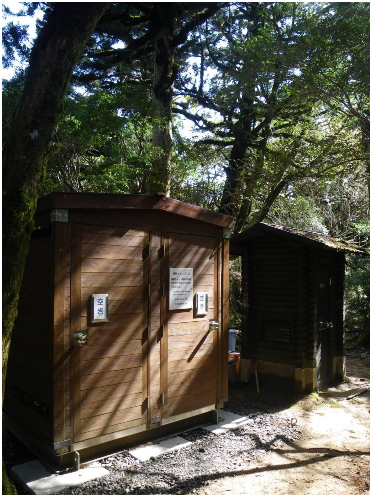
淀川小屋の携帯トイレブース(左)と既設汲取り式トイレ(右)
